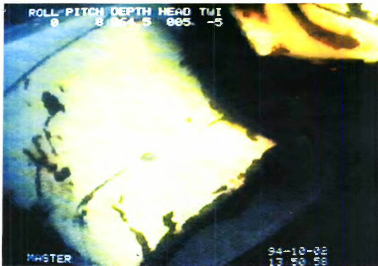
11.5 Visiiri liikumise ajal käituri poolt eesmisele vaheseinale põhjustatud kahjustused
